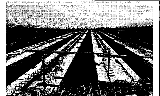
照片 8：吊放後-木料角材橫向連結
