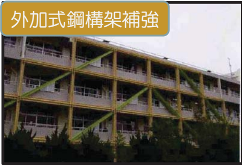
外加式鋼構架補強
